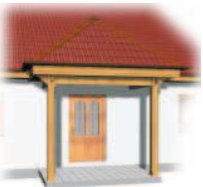
přístřešek se sloupy s valbovou střechou
